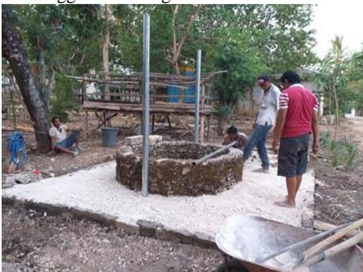
Gambar 8. Pembuatan lantai sumur
