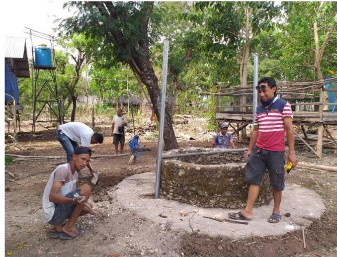
Gambar 7. Pemasangan tiang sumur
