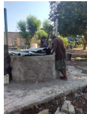
Gambar 9. Dinding sumur yang sudah ditinggikan
