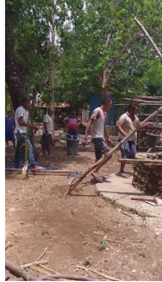
Gambar 5. Pembersihan sampah dan lumpur sumur
