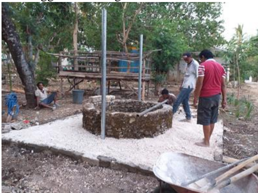
Gambar 8. Pembuatan lantai sumur
