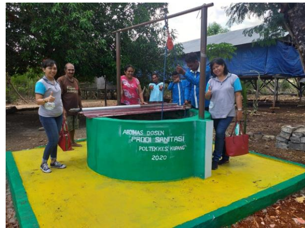
Gambar 13. Sumur gali setelah diperbaiki
