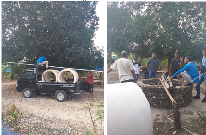
Gambar 3. Pendistribusian material perbaikan SAB
