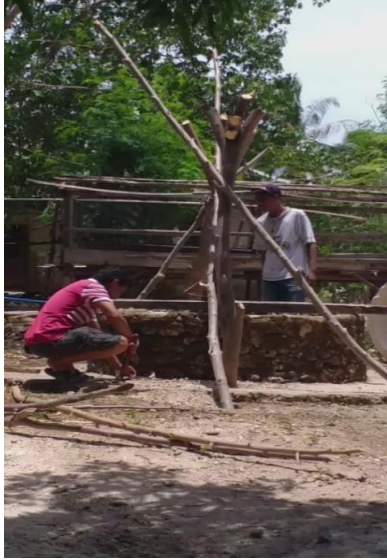
Gambar 4. Pembuatan tiang penyangga
