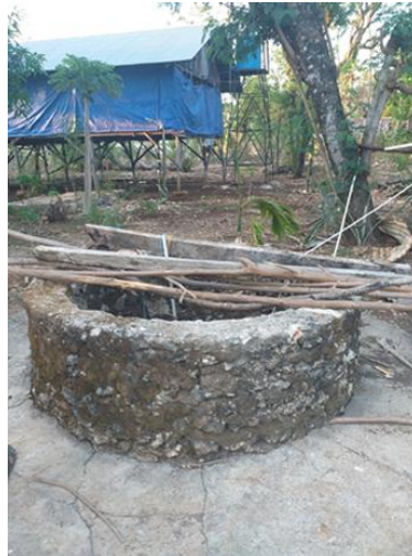
Gambar 2. Kondisi awal sumur gali
