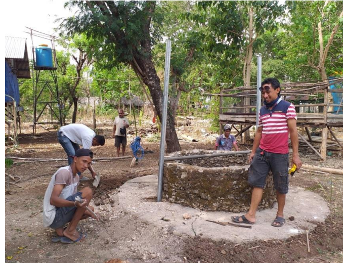
Gambar 7. Pemasangan tiang sumur
